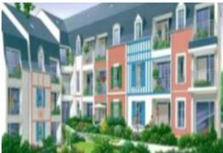
34 logements à loyer accessible à Trouville
